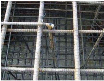
수화열 계측기 설치
