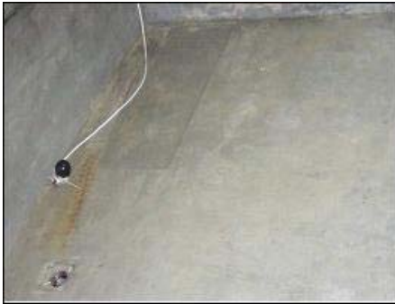
보호판 설치 전
