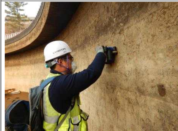
③ 구조물 내구성조사 현황
